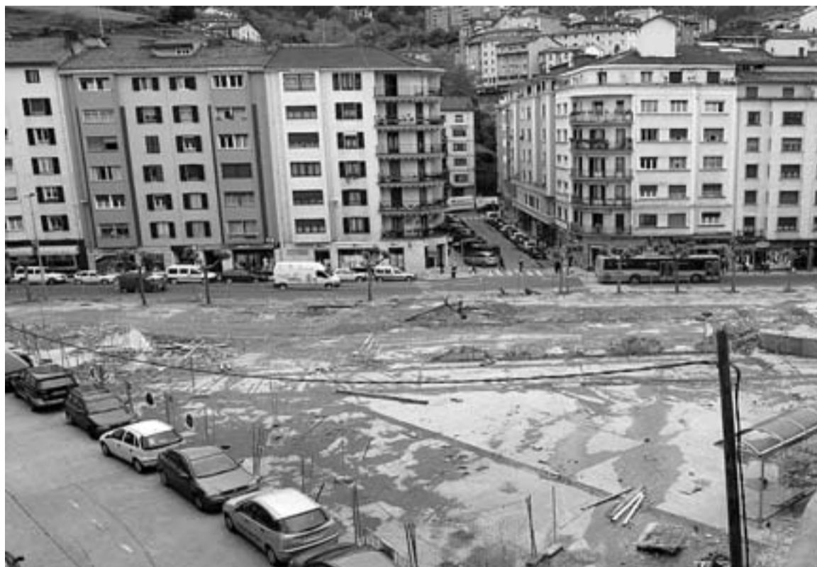
OBRAS. Vista del solar donde se ubicaba la plaza de abastos de Eibar. / JULIO CALLEJA
